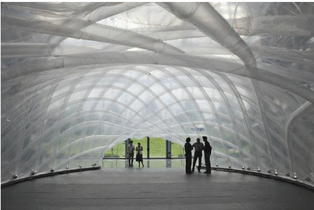
Abbildung 48 PLUSMINUS - Pneumatische Gitterschale – selbsttragende Struktur mit luftgefüllten Schläuchen<sup>103</sup>
