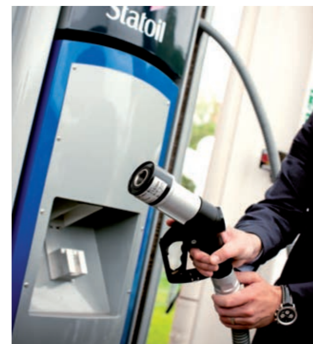
Abbildung 25: 700-bar-Zapfsäule an der CEP Tankstelle Berlin Holzmarktstraße (Quelle: CEP)
