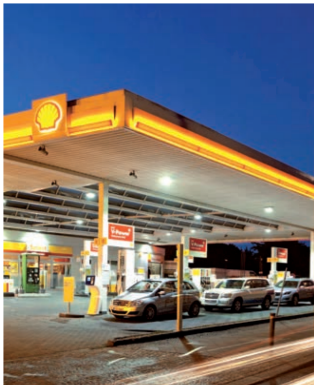
Abbildung 4: Wasserstoff-Tankstelle Berlin Sachsendamms Tankstelle Shell
