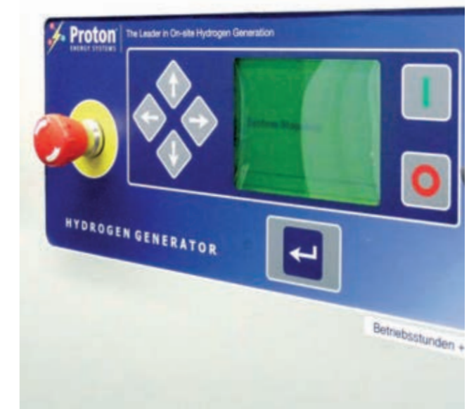
Abbildung 19: Onsite-Elektrolyse-Systeme PEM Elektrolyseur der Firma Proton Onsite (früher Proton Energy Systems) an der Wasserstoff-Tankstelle am Fraunhofer ISE, Freiburg (links: Verfahrenstechnischer Aufbau, rechts: Bedienpanel)
