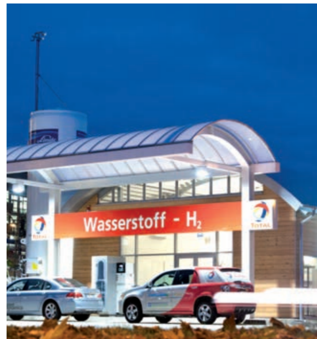
Abbildung 11: Wasserstoff-Tankstelle mit On-site-Erzeugung Berlin Holzmarktstraße (Quelle: TOTAL/Pierre Adenis)
