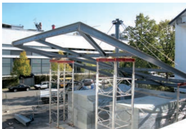
Abbildung 38: Wasserstoff-Tankstelle am Fraunhofer ISE, Freiburg – im Bau
