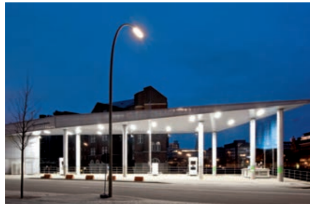
Abbildung 26: Wasserstoff-Tankstelle von Vattenfall in der Hamburger Speicherstadt (Quelle: Vattenfall Europe)
