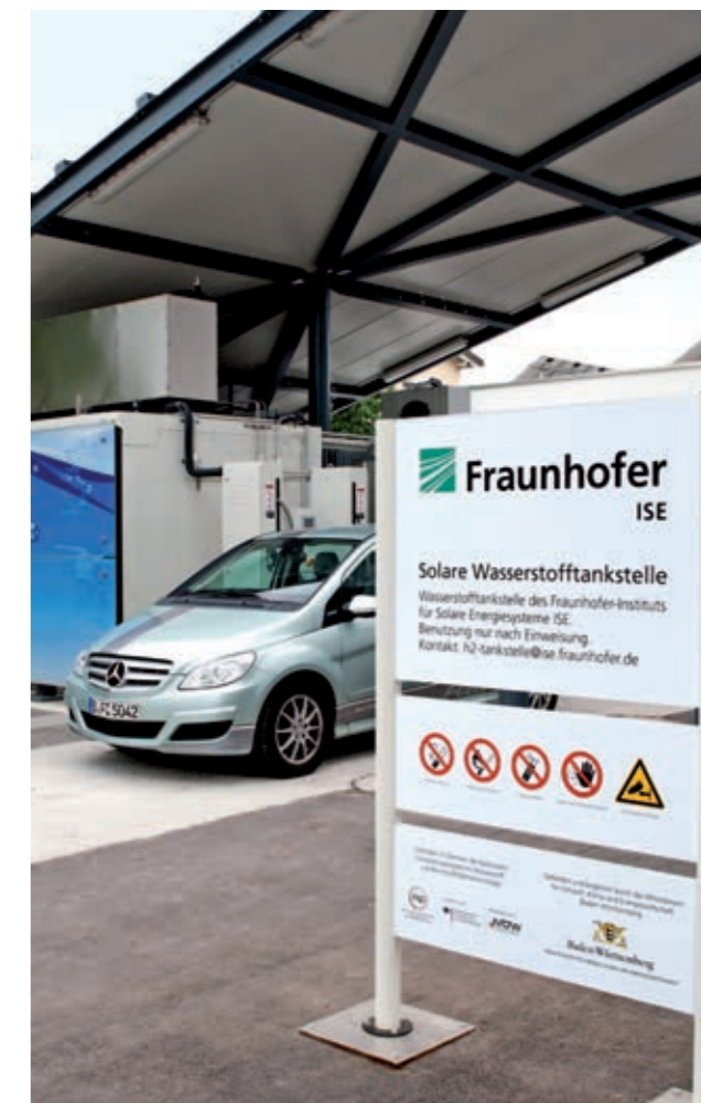
Abbildung 39: Wasserstoff-Tankstelle am Fraunhofer ISE, Freiburg – abgeschlossen
