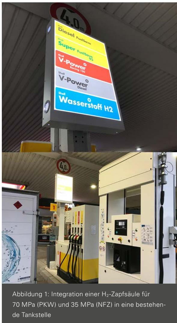
Abbildung 1: Integration einer H<sub>2</sub>-Zapfsäule für 70 MPa (PKW) und 35 MPa (NFZ) in eine bestehende Tankstelle
